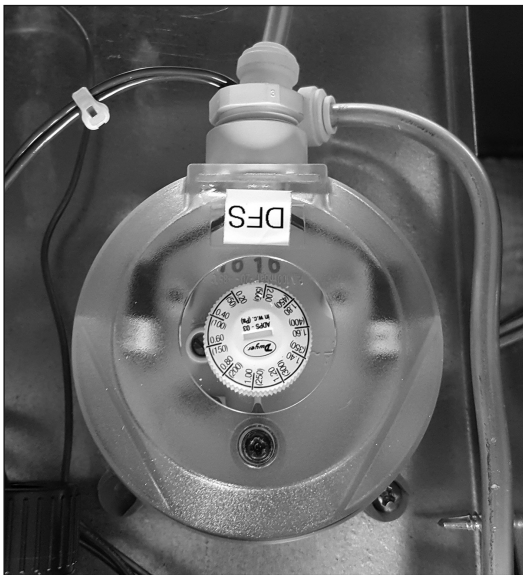
Figure 26.3 – Pressostat « filtre sale »
